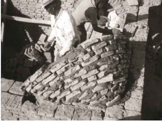
Görsel 12: İran'da Javadabad İlkokulu'nun Tonzoları ve Kubbelerinin İnşası
