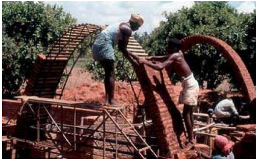
Görsel 16: Mekanizmalı Çelikten Kemer Kalıbı ve Kubbeli Orta Odanın Tonozlarla Bağlantısı
