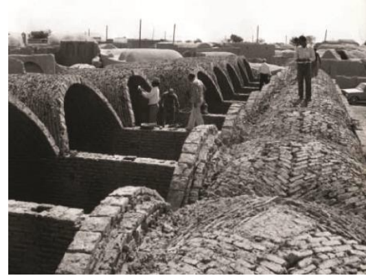
Görsel 12: İran'da Javadabad İlkokulu'nun Tonzoları ve Kubbelerinin İnşası
