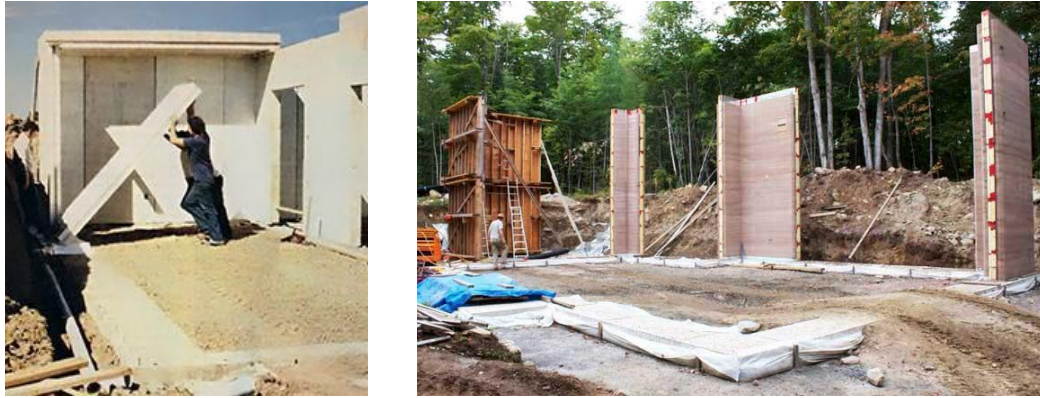
Görsel 3: Hazır Toprak Panellerin İnşa Etmesi
