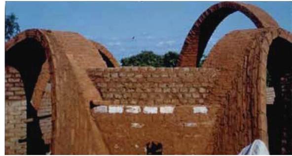
Görsel 16: Mekanizmalı Çelikten Kemer Kalıbı ve Kubbeli Orta Odanın Tonozlarla Bağlantısı
