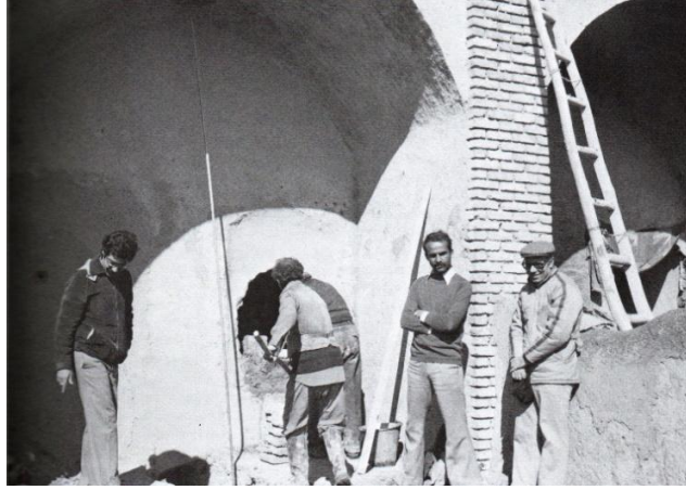
Görsel 10: Duvardaki Açıklıkların Harçsız Kerpiç Tuğlalar İle Kapatılması
