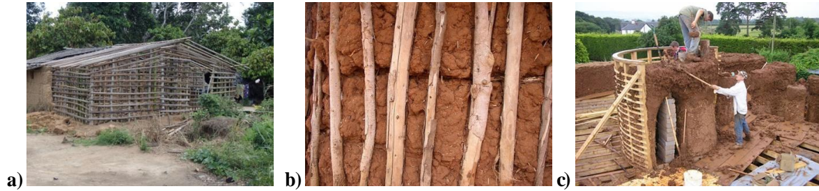
Görsel 6: Omurgalı Kerpiç Duvar Yapım Tekniği
