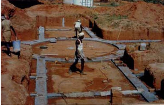
Görsel 15: Duvarların, Çimentodan Dayanma Ayağı ve Zemin Düzeyinin Altından Başlaması
