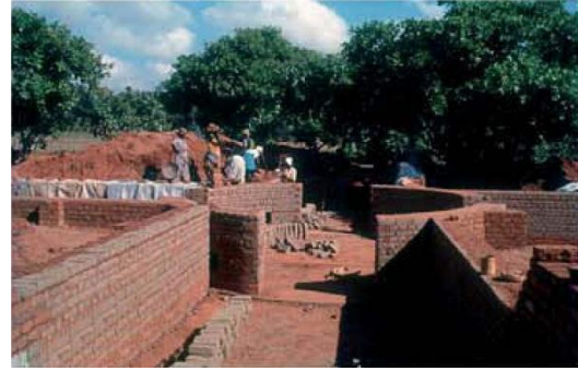
Görsel 15: Duvarların, Çimentodan Dayanma Ayağı ve Zemin Düzeyinin Altından Başlaması
