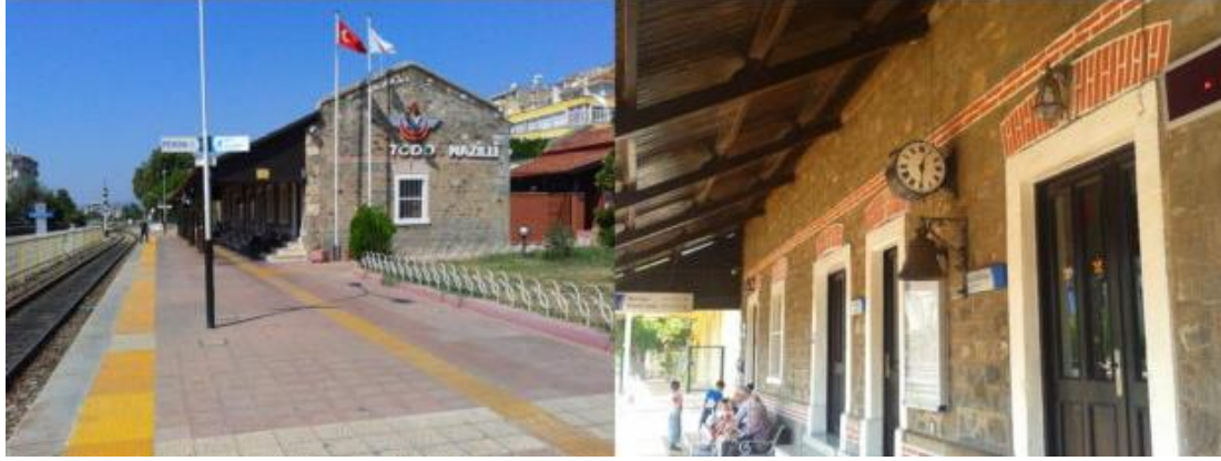
Şekil 7. Kasabamın İstasyon Binası (Ilgın 2016, otekisinema.com)
