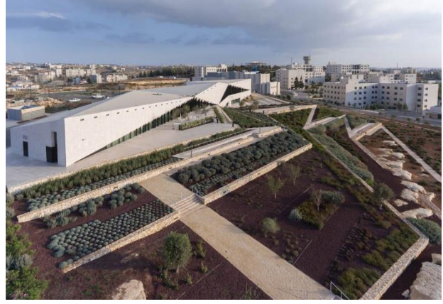
Şekil 6. Yapının Batısında Yer Alan Açık Alanlar
