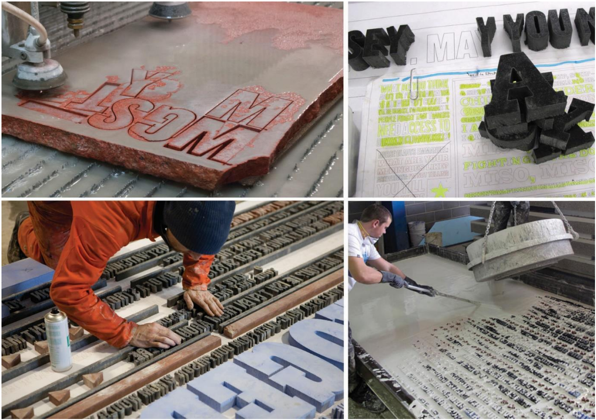
Resim 6: Comedy Carpet (Komedi Halısı), Gordon Young ve Uygulama Ekibinin Granit Harfbloklarını Kesim ve Yapım Aşamaları, 2011
