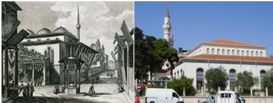
Resim 3. Ulu Camii (Hüdavendigâr Camii) ve Günümüzdeki Hali (E. Bahtiyar Arşivi, URL-6).
