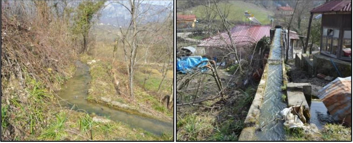
Fotoğraf 1. Değirmene Su Getiren Kanal ve Değirmen Çalıştırılmadığı Zamanlarda Su Tahliye Arkına Yönlendirmeye Yarayan Ark Düzeneğinden Birer Görünüm. Kaynak: Yazar arşivi.
