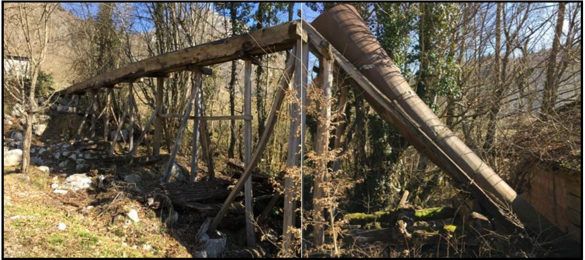
Fotoğraf 2. Su Kemerli Yardımıyla Oluğa Ulaşan Su, Değirmenin Çalışabilmesi İçin Yaklaşık 60° Eğimle Yaklaşık 5-6 m'den Düşürülmesi. Kaynak: Yazar arşivi.
