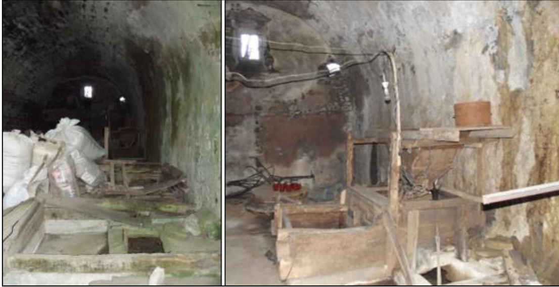
Fotoğraf 8. Kemerli Bir Kapıdan Girilen Yedi Ocaklı Rum Değirmeni; Ortalama 17 Metre Uzunluğunda, 5 Metre Genişliğinde ve 7 Metre Yüksekliğindedir ve Taş Tonoz Örtü Sistemi İle Yapılmıştır.
