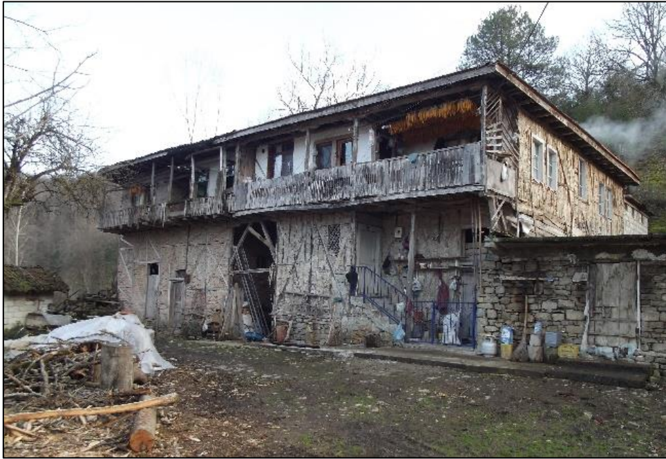
Fotoğraf 9. Yedi Ocaklı Değirmen’in üst katı ahşap karkas sistem ile yapılmıştır. Yapıya daha sonradan ahır gibi unsurlar da eklenmiştir. Kaynak: Yazar arşivi.
