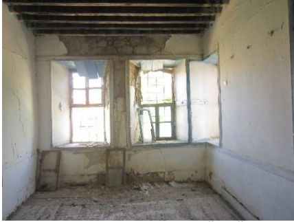
Fotoğraf 34. Ahşap Kirişleme Üst Örtülü Oda, 2017 (Yazarın Kişisel Arşivi)
