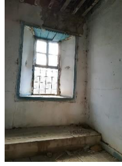
Fotoğraf 35-36. Aydınlatmada Enerji Verimliliği Sağlayan Mazgal Pencere, 2017 (Yazarın Kişisel Arşivi)
