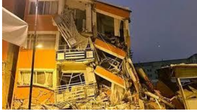
Şekil 5: 2023 Kahramanmaraş Depreminde Yıkılan Bir Bina (Gazetevatan, 2023)
