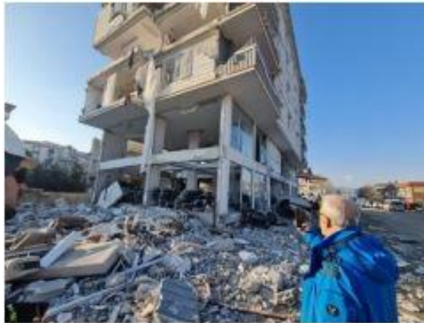
Şekil 4: 2023 Kahramanmaraş Depreminde Yıkılan Bir Bina (ODTÜ, 2023)
