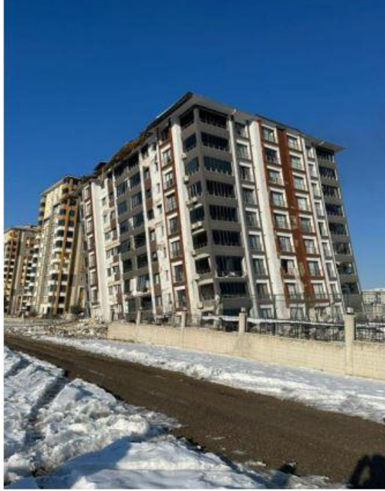
Şekil 3: 2023 Kahramanmaraş Depreminde Malatya’da Yıkılan Bir Bina (Akbaş, Çalışkan, 2023)
