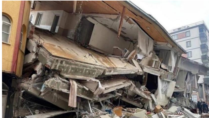
Şekil 7: 2023 Kahramanmaraş Depreminde Yıkılan Bir Bina (Pusulagazetesi, 2024)
