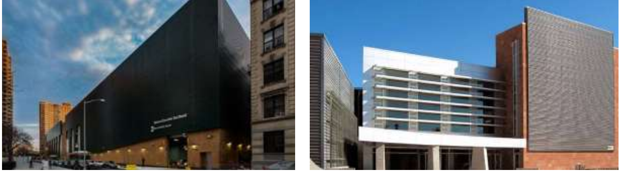
Şekil 11. Güneş Duvarı Örnekleri, Mother Clara Hale Terminali, ABD-Kuzey Arizona Üniversitesi, Kanada (Url-12)
