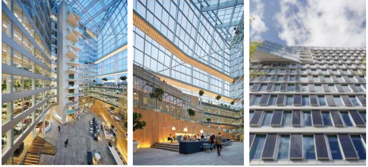
Şekil 26. The Edge, Atrium ve Güney Cephede Yer Alan PV Paneller (Url-18)
