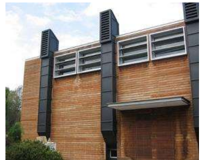
Şekil 1. Güneş Bacası Çalışma Prensibi ve Örnekleri (Url-1, Url-2, Url-3)
