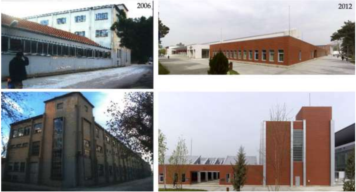
Şekil 19: İplik Fabrikası Değiştirilen Pencere Düzeni Dış Cephe Kaplaması.
