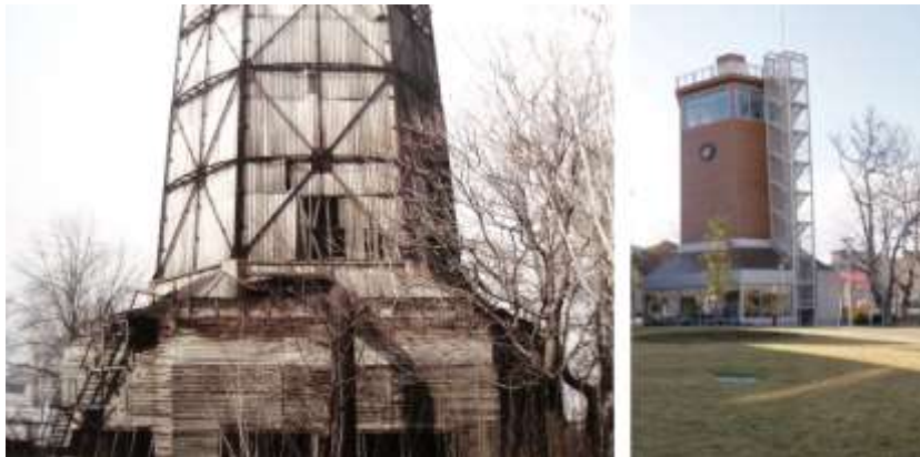
Şekil 21: Su Soğutma Kulesi (öncesi-sonrası) ( http://www.bursamuze.com/merinos-enerji-muzesi-505/ )
