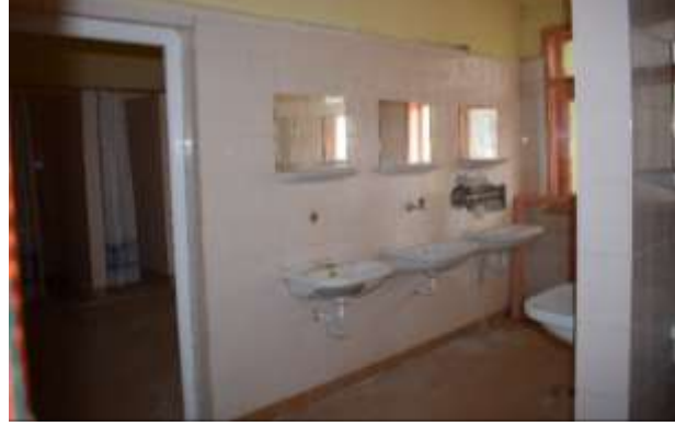
Fotoğraf 8: Pamukpınar Köy Enstitüsü Yatakhane Binası- Duşluk ve Lavabolar
