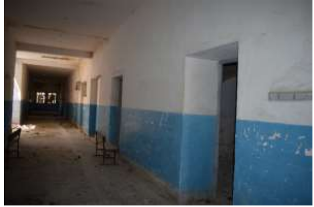
Fotoğraf 2: Pamukpınar Köy Enstitüsü Okul Binası-Koridor
