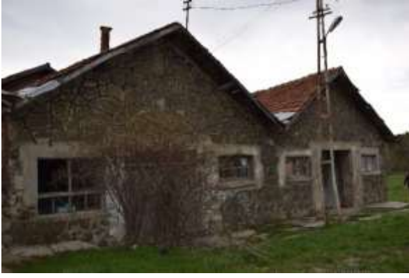
Fotoğraf 18: Pamukpınar Köy Enstitüsü Demircilik Atölyesi ve Marangozhane Binalarının Girişleri
