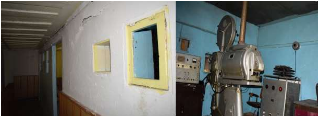
Fotoğraf 17: Pamukpınar Köy Enstitüsü Yemekhane Binası- Asma Kat
