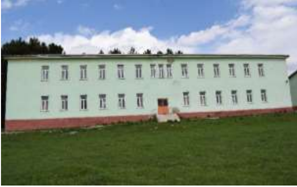
Fotoğraf 9: Pamukpınar Köy Enstitüsü Toplantı Binası
