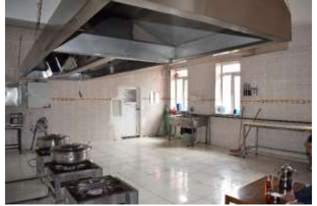
Fotoğraf 16: Yemekhane Binası- Mutfak
