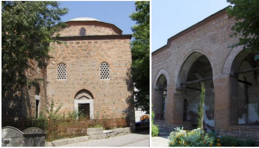
Şekil 8. Şehabeddin Paşa Camii Dış Cephe (Yazara ait fotoğraf arşivi)
