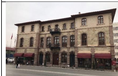
Fotoğraf 19. Giriş (Batı) Cephesi (Fot. Dicle Aydın, 2020)
