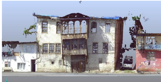
Şekil 13. Cephe Hattındaki ve Cumbadaki Sapmaları Tespitine Yönelik Lazer Tarama Teknolojisi ile Belgelenmiştir.
