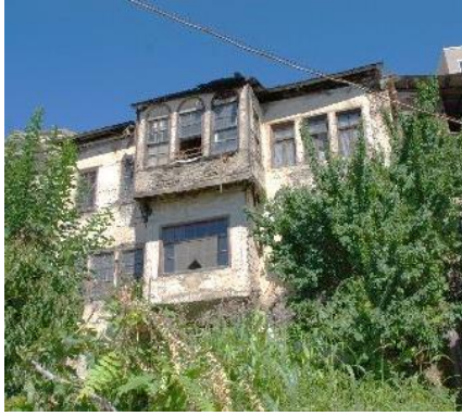
Şekil 7. Değirmenlik Mahallesi Konut
