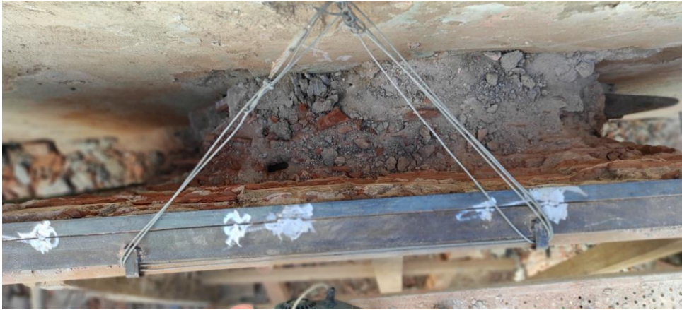
Şekil 10. Köylü Pazarı mozaik pano duvar desteğinin bağlanması (Tülay Özkul'un kişisel arşivinden)
