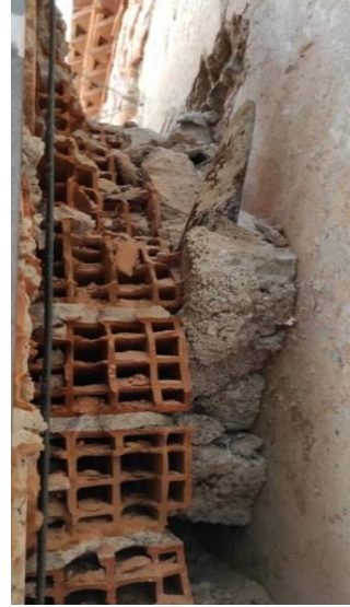
Şekil 9. Köylü Pazarı mozaik pano duvardan ayırma işlemi detay (Tülay Özkul'un kişisel arşivinden)
