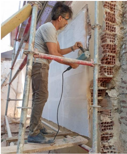
Şekil 6. Köylü Pazarı mozaik pano metal çerçeve için yol açılması (Tülay Özkul'un kişisel arşivinden)
