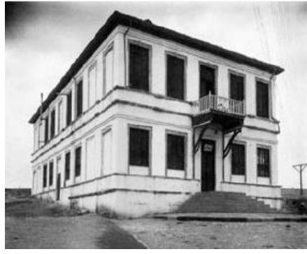
Resim 10. Belediye Sineması olarak kullanılmış olan Tiyatro Binası (Tatbikat Okulu). 83
