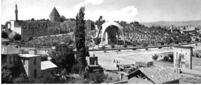
Resim 7. 1960 lı yıllarda Alaadin Cami, Sultan Kılıçarslan Köşkü ve koruma amacı ile yapılan betonarme kabuk (Koyunoğlu Müzesi Arşivinden)
