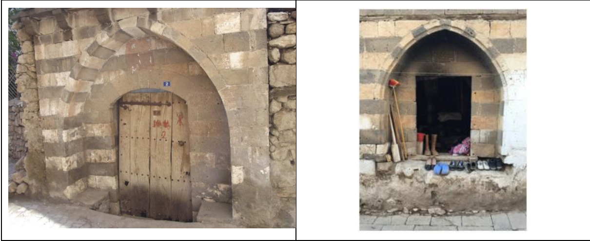
Şekil 9. Avlu Kapısı ve Ana Bina Kapısı
