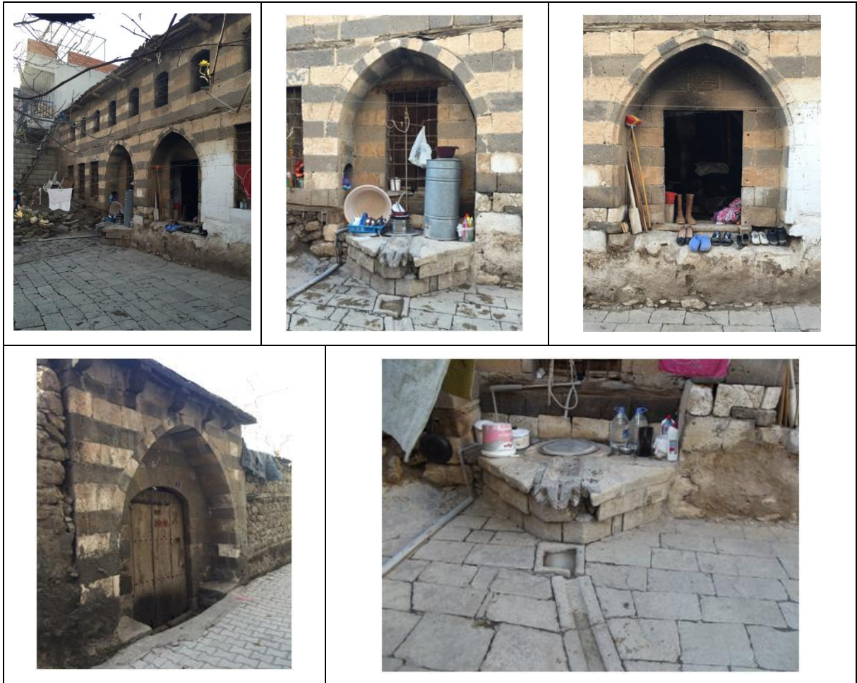
Şekil 8. Avluya Girişi Sağlayan Özgün Taç Kapı, Avlu Cephesinde Yer Alan Su Düzeneği ve İbadet Mekanına Girişi Sağlayan Sonradan Kapatılan Kapı
