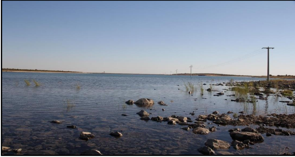
Fotoğraf 5. Taşbasan Su Depolama Alanından Görünüm
