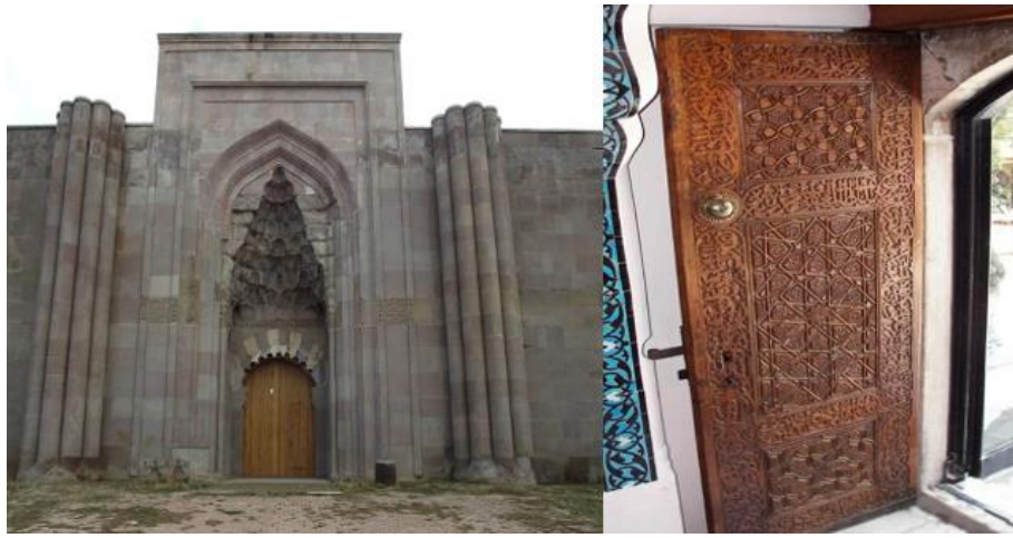
Resim 36. Kayseri Sultan Hanı Taçkapısı, Bursa Yeşil Türbe Künde-kari ve Oyma İşçiliği Kapı (URL-49).
